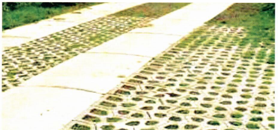
Фото 1. Дорога в Германии с колеиным покрытием из плит, ответвление дороги выложено решетчатой газонной плиткой
