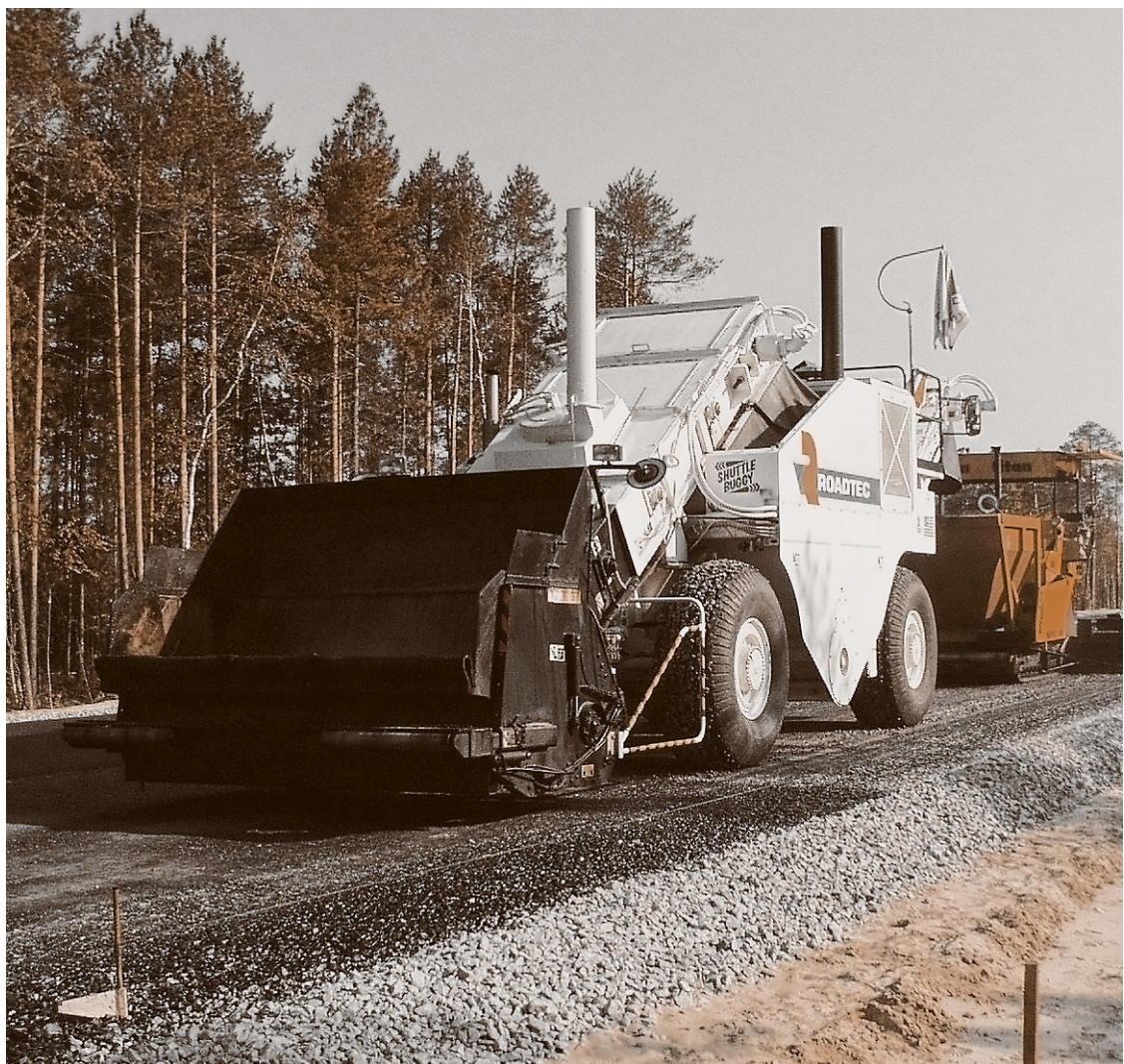
Комплекс для устройства асфальтобетонного покрытия Шаттл Багги.
