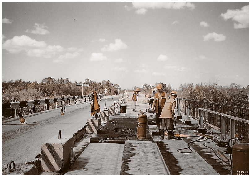
Устройство трещино- прерывающего слоя на участке автомобильной дороги Сургут — Нижневартовск.
