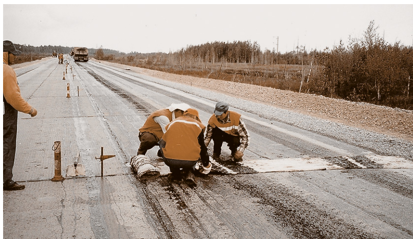
Устройство трещино- прерывающего слоя на участке автомобильной дороги Сургут — Нижневартовск.
