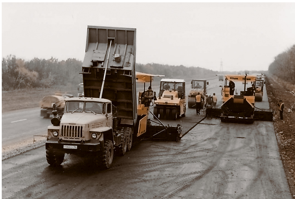
Устройство асфальтобетонного покрытия.
