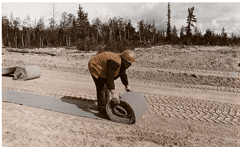
Применение геотекстильных материалов при строительстве автомобильной дороги.
