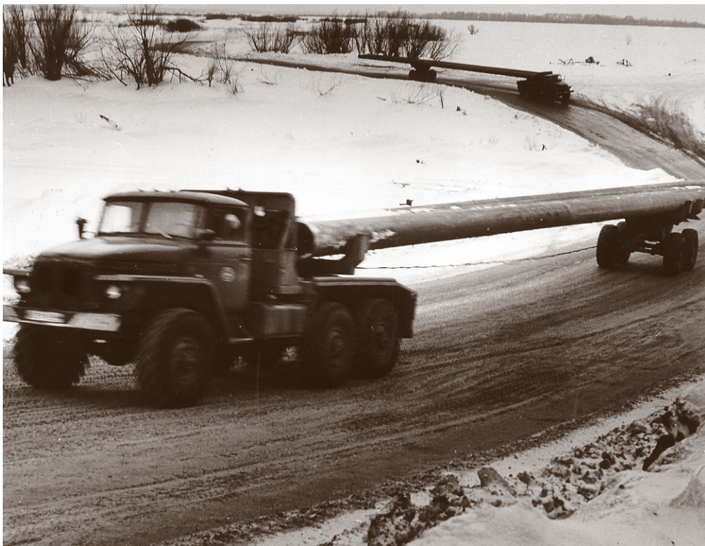
Вывозка двухтрубных секций по зимнику.
