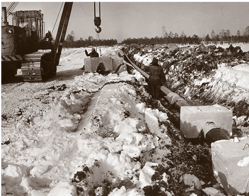
Установка балластирующих устройств на трубопровод.
