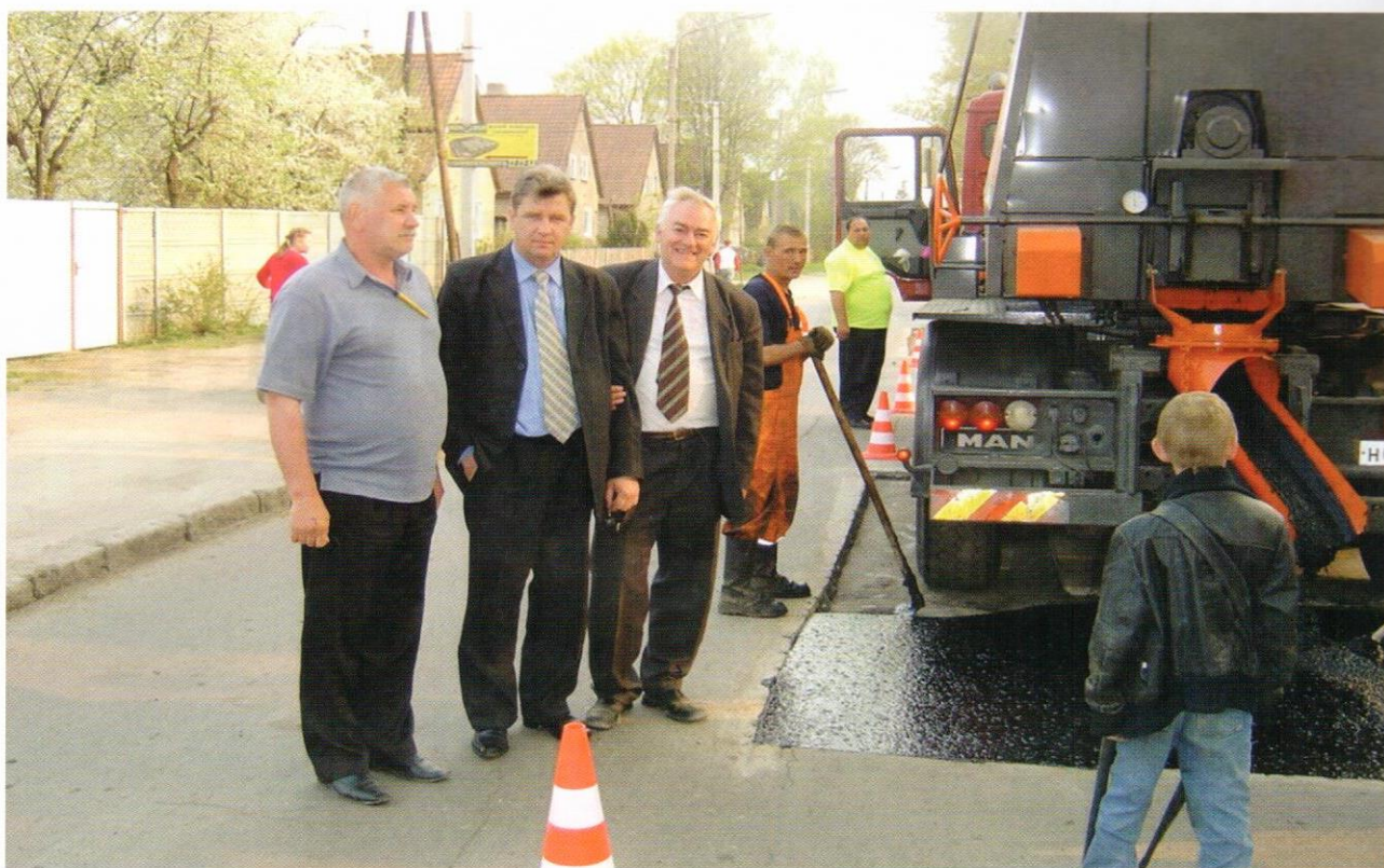
Фото 4. Укладка литой смеси с 50% асфальтогранулята на одной из улиц г. Калининграда
