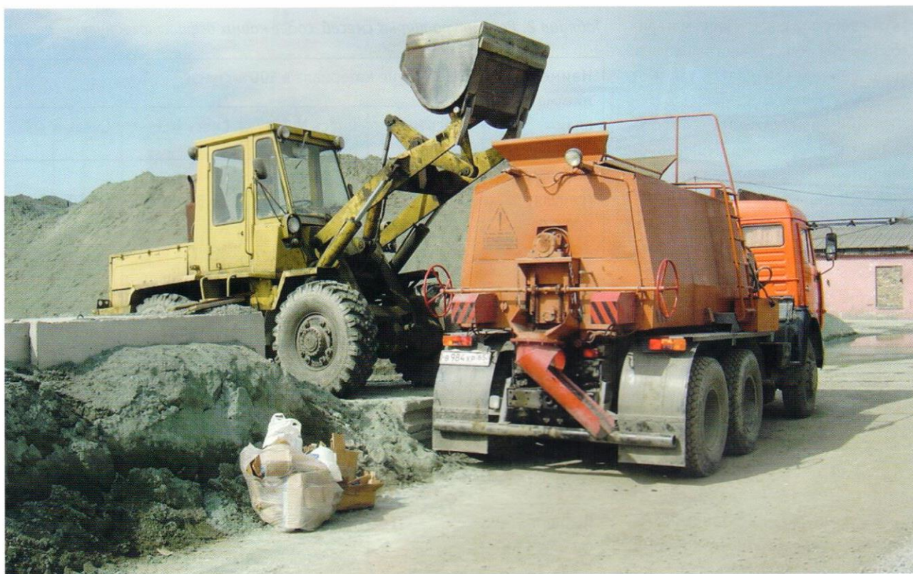
Фото 3. Погрузка материалов в мобильный кохер ОРД-1025 (г. Южно-Сахалинск)
