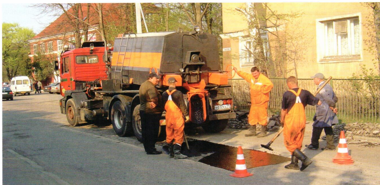
Фото 1. Ямочный ремонт дорожного покрытия с использованием литой асфальтобетонной смеси и термоса-миксера (кохера)
